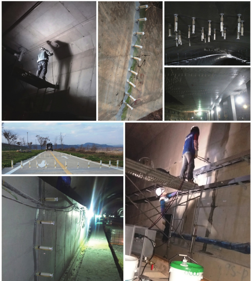
(Hình ảnh thi công)
