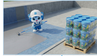
Thi công lớp tiếp theo Thi công (các) lớp tiếp theo vuông góc với lớp trước.
