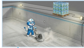
Chuẩn bị bề mặt Làm sạch, tạo nhám nhẹ, đảm bảo bề mặt chắc và đồng đều.
