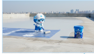
Gia cường lưới (khi cần) Đặt lưới gia cường vào lớp thứ nhất còn ướt khi bề mặt sàn phẳng rộng hơn 200m 2 .
