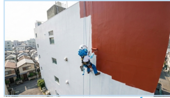
Thi công lớp thứ nhất Lăn lớp thứ nhất mỏng và dàn đều để tạo độ bám chắc chắn, tránh lăn quá định mức 0,5kg/m 2 .
