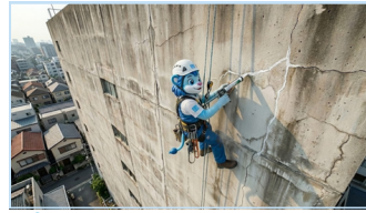
Xử lý vị trí chưa phù hợp Xử lý vết nứt tĩnh, lỗ rỗng, góc và khe tiếp giáp.
