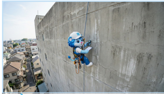
Kiểm tra trước thi công Kiểm tra thời tiết, độ ẩm và tình trạng bề mặt trước khi thi công.
