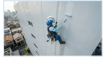
Lăn lớp sơn lót Trộn đều và lăn lớp sơn lót để tăng bám dính hoặc kháng ẩm nếu tường tô còn ẩm ướt.
