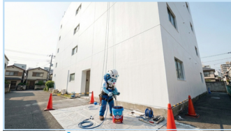
Trộn đều vật liệu Trộn đều sản phẩm WALLCOAT trước khi thi công lớp thứ nhất.
