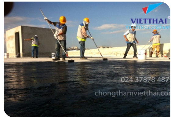
Thi công lăn lớp lót
