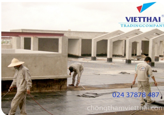
Thi công màng khò nóng
