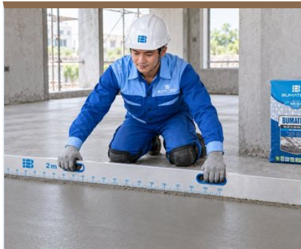
Cán nền bằng vữa khô trộn sẵn Sc 100
