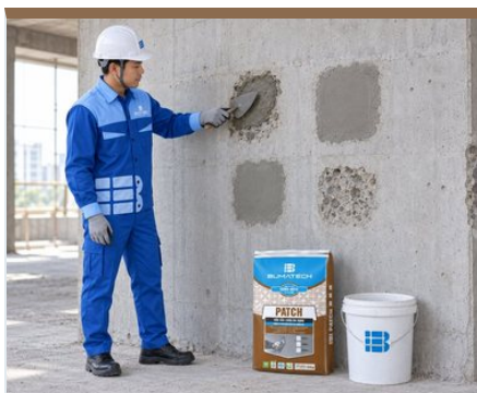
Vá ổ rỗ tổ ong và khuyết tật bề mặt bằng PATCH 20
