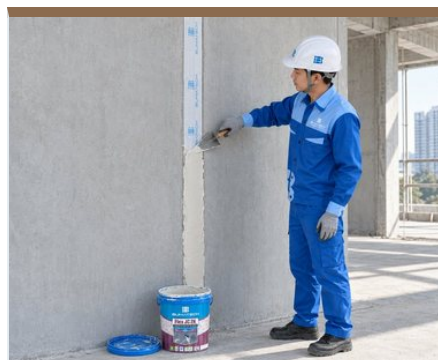
Trét FLEX JC 2K và chèn lưới thủy tinh vào mối nối tấm tường
