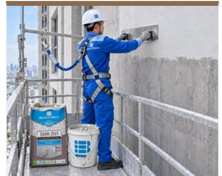
Bả Skim 2in1 EX lên tường bê tông nhà cao tầng
