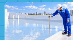
10 Ngâm thử nước kiểm tra
