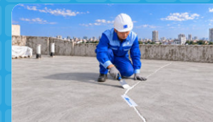
3 Trám nứt bằng vữa sửa chữa
