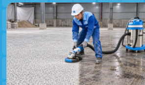
1 Chuẩn bị bề mặt
