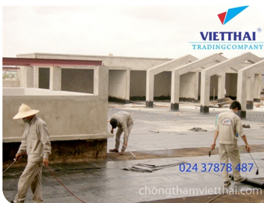
Thi công màng khò nóng
