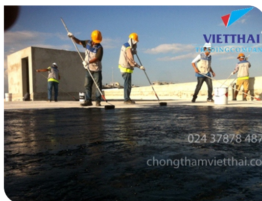
Thi công lăn lớp lót
