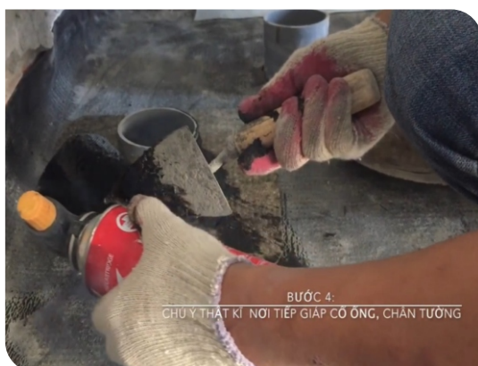
Xử lý cổ ống thoát nước
