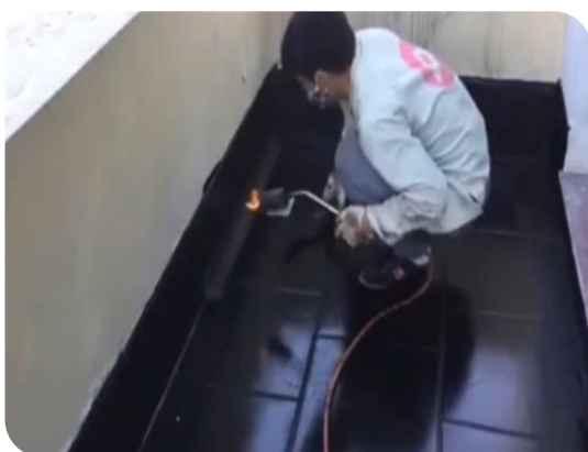
Xử lý góc chân tường
