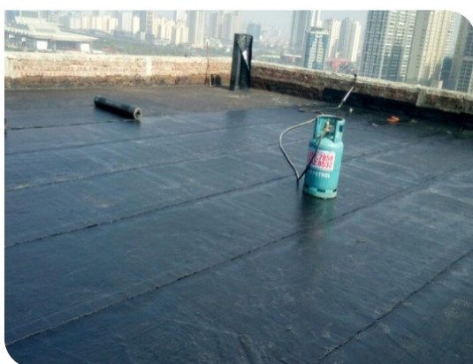
Bề mặt hoàn thiện
