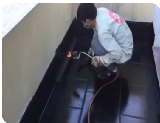
Xử lý góc chân tường
