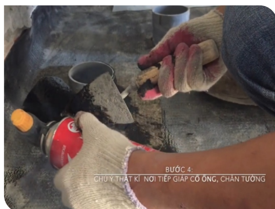
Xử lý cổ ống thoát nước
