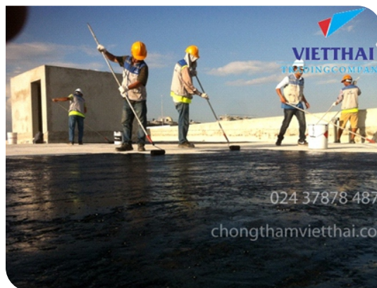
Thi công lăn lớp lót
