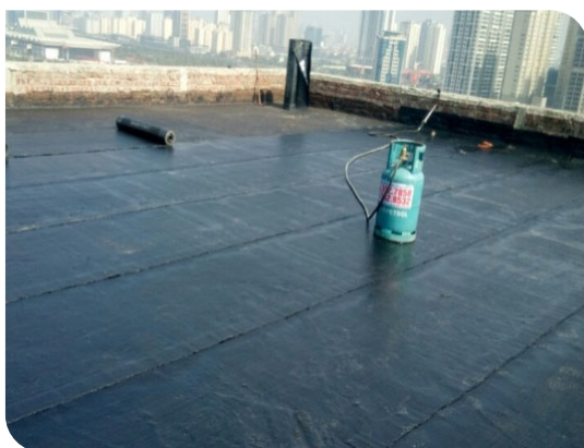
Bề mặt hoàn thiện
