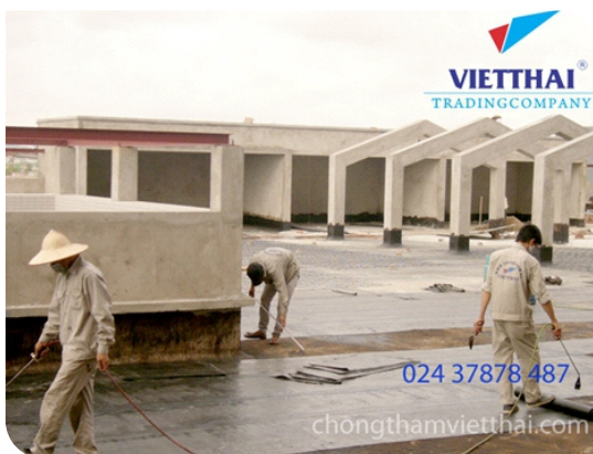
Thi công màng khô nóng
