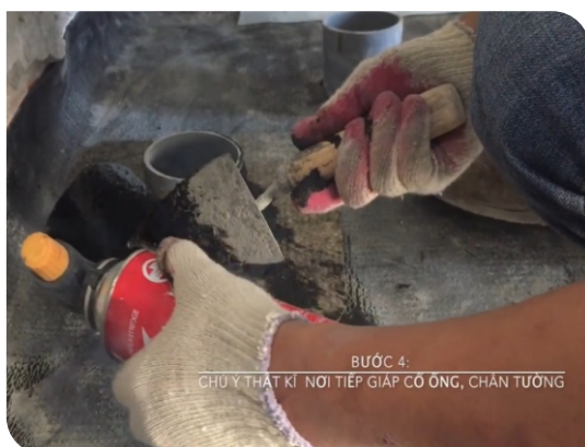
Xử lý cổ ống thoát nước
