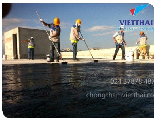
Thi công lăn lớp lót
