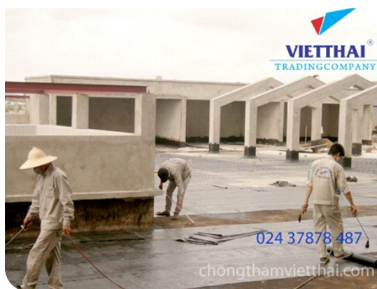
Thi công màng khô nóng
