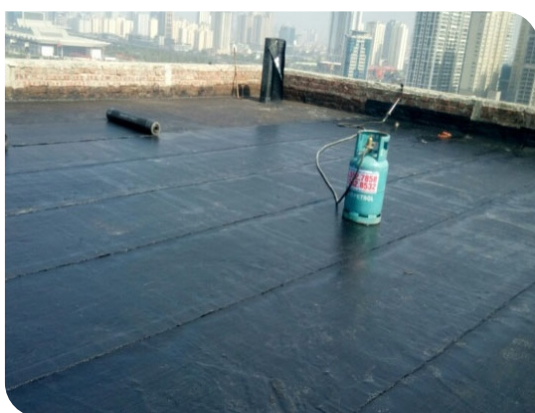
Bề mặt hoàn thiện
