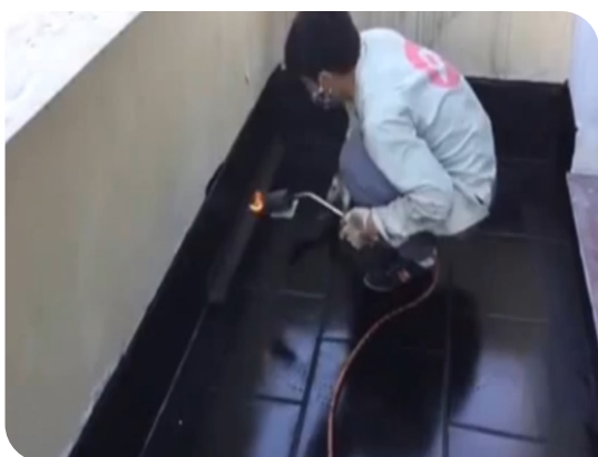
Xử lý góc chân tường
