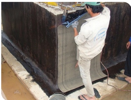
Thi công màng khô nóng
