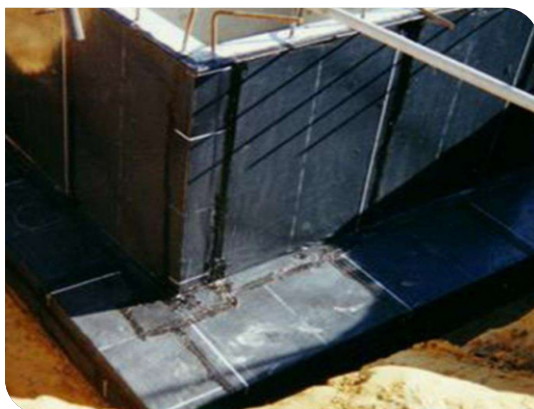
Bề mặt hoàn thiện
