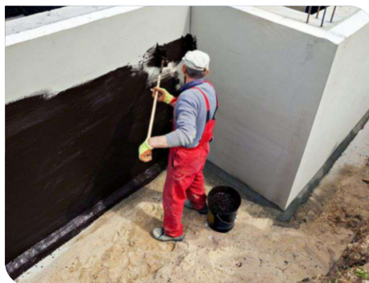
Thi công lăn lớp lót
