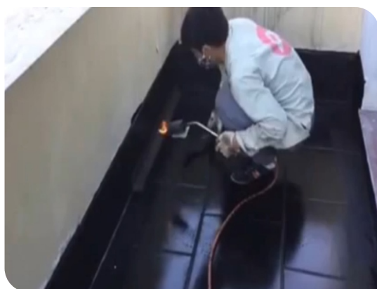
Xử lý góc chân tường
