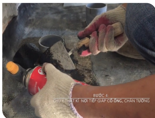
Xử lý cổ ống thoát nước
