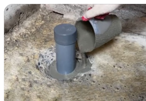
Thi công đổ vữa Lemax Grout LM-G650
