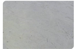
Bề mặt bê tông đạt
