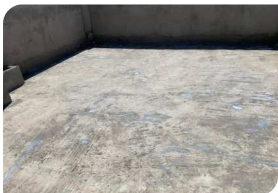
Chuẩn bị bề mặt
