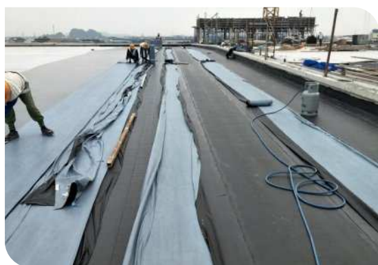
Thi công màng khô nóng
