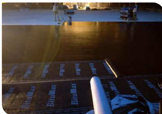
Thi công lăn lớp lót
