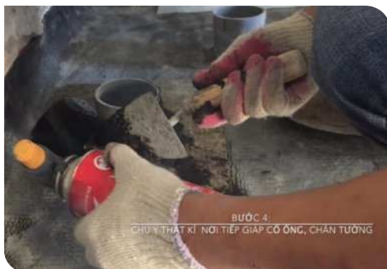
Xử lý cổ ống thoát nước
