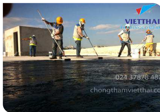
Thi công lăn lớp lót
