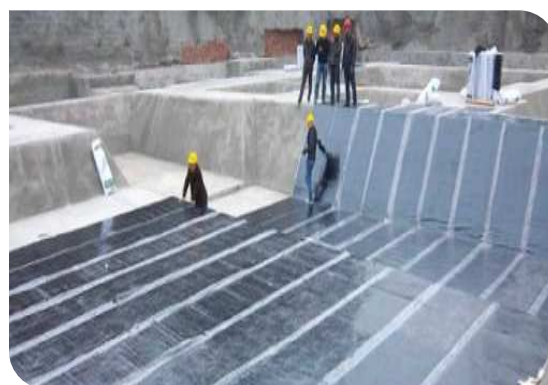
Bề mặt hoàn thiện
