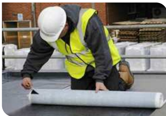
Thi công màng tự dính
