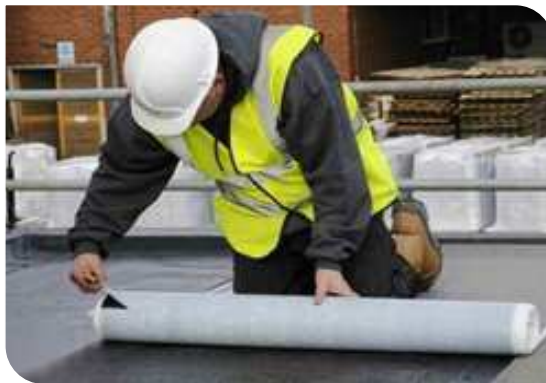
Thi công màng tự dính
