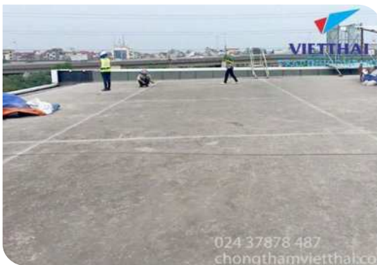
Chuẩn bị bề mặt
