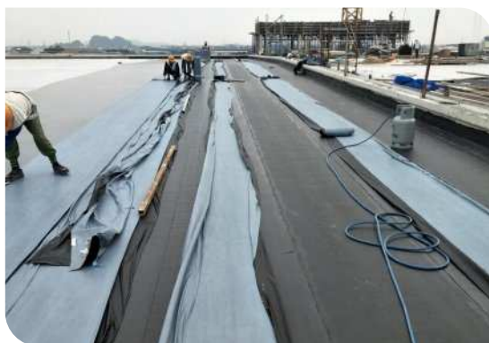
Thi công màng khò nóng
