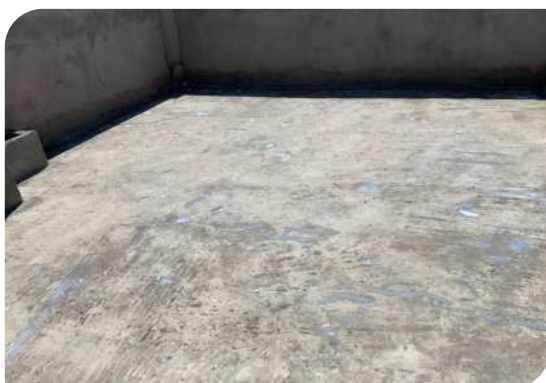
Chuẩn bị bề mặt
