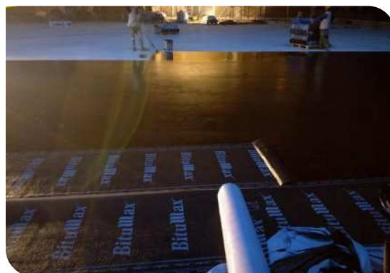
Thi công lăn lớp lót
