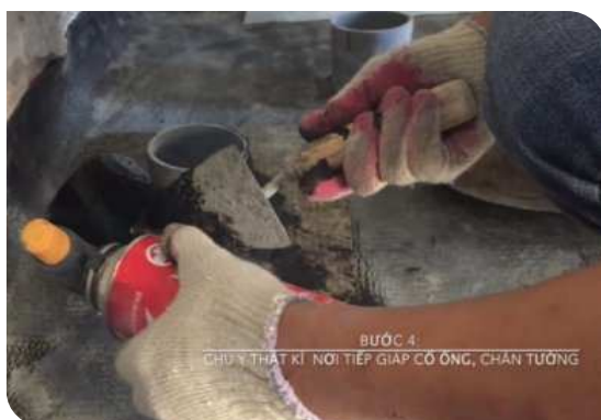
Xử lý cổ ống thoát nước
