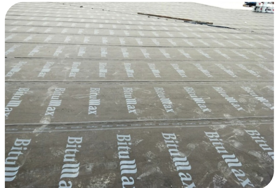
Bề mặt hoàn thiện
