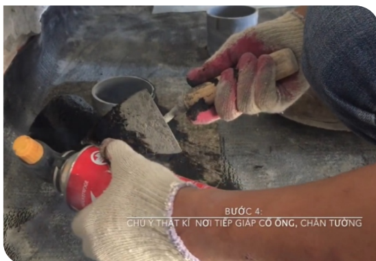
Xử lý cổ ống thoát nước
