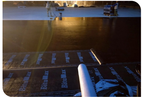
Thi công lăn lớp lót
