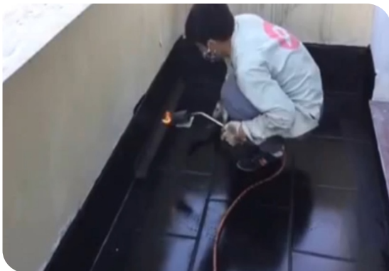
Xử lý góc chân tường
