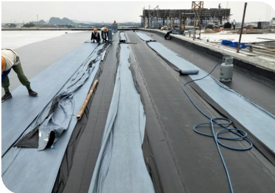
Thi công màng khô nóng
