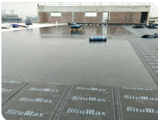
Thi công màng tự dính
