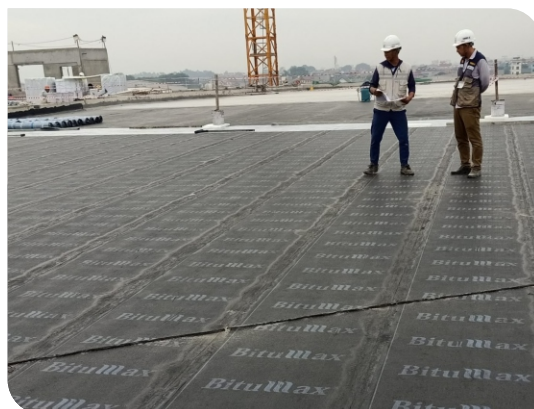
Bề mặt hoàn thiện
