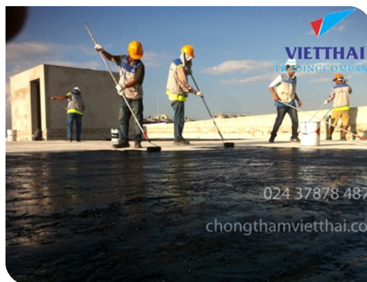
Thi công lăn lớp lót
