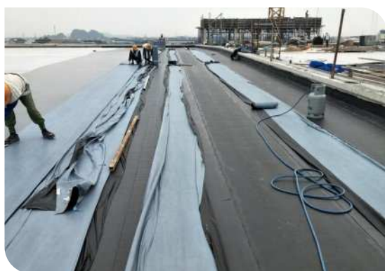
Thi công màng khô nóng
