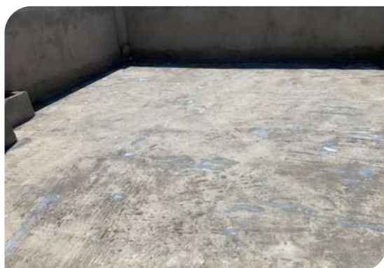
Chuẩn bị bề mặt
