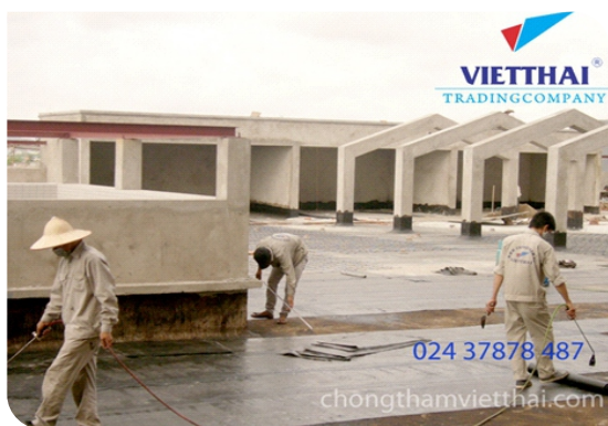
Thi công màng khò nóng
