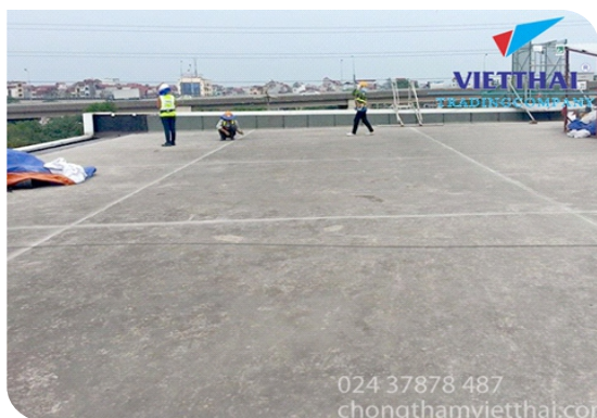
Chuẩn bị bề mặt
