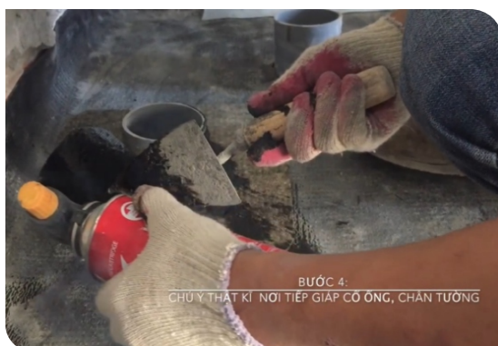
Xử lý cổ ống thoát nước
