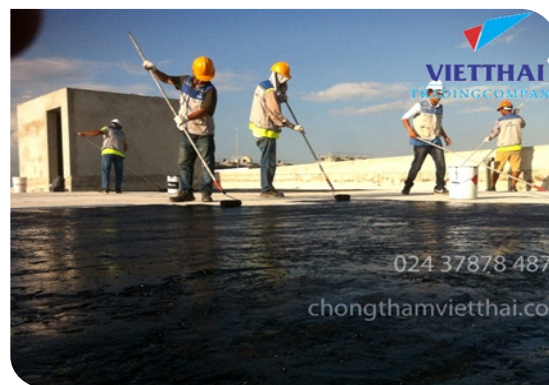
Thi công lăn lớp lót
