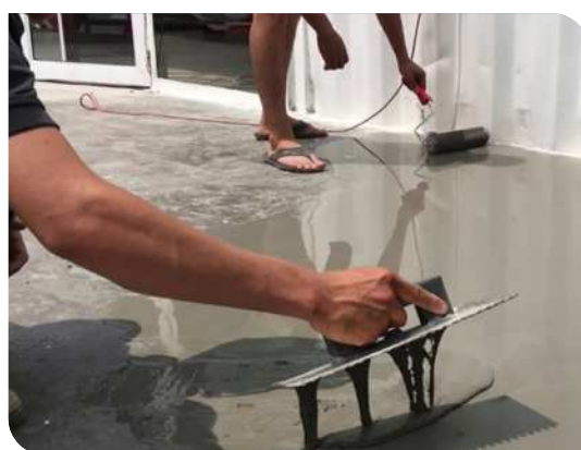
Thi công cán hồ dầu
