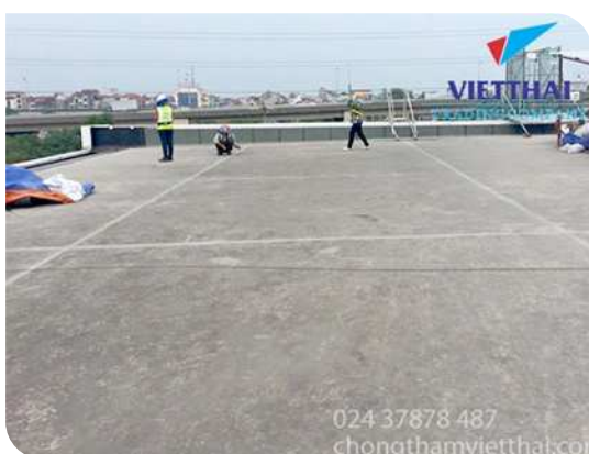
Chuẩn bị bề mặt
