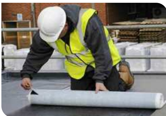
Thi công màng tự dính
