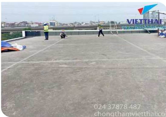
Chuẩn bị bề mặt
