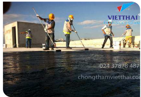
Thi công lăn lớp lót
