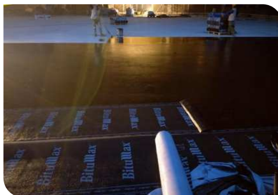
Thi công lăn lớp lót
