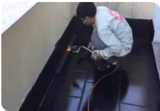
Xử lý góc chân tường
