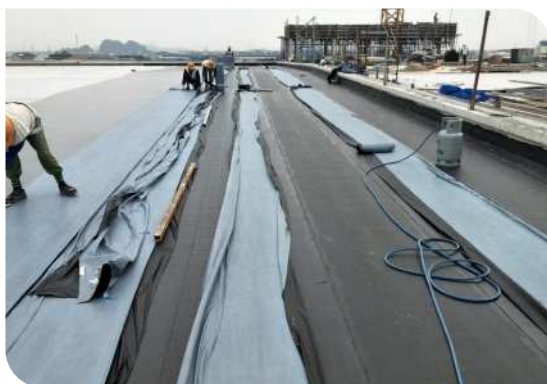
Thi công màng khô nóng
