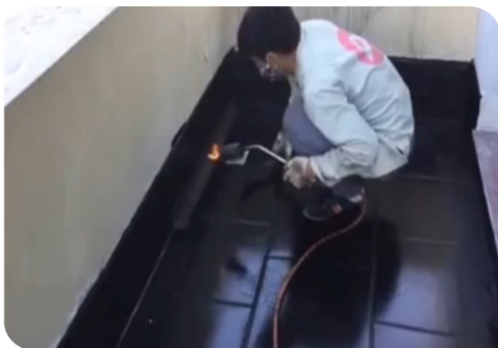
Xử lý góc chân tường
