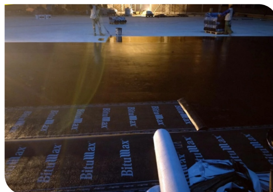
Thi công lăn lớp lót
