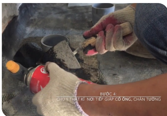
Xử lý cổ ống thoát nước
