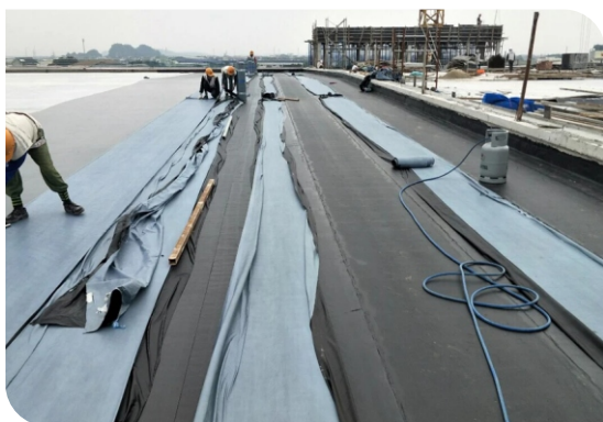
Thi công màng khô nóng
